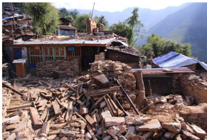
Figure 2 Dégâts à Yamgaon
